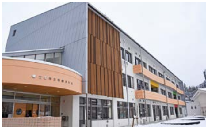
2 月／利根小学校校舎完成
