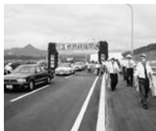
8 月／薄根跨線橋が開通
