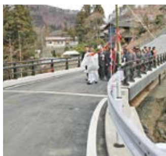
3 月／新青木大橋が完成
