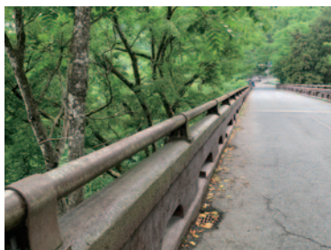
昭和24年に築造した千歳橋
