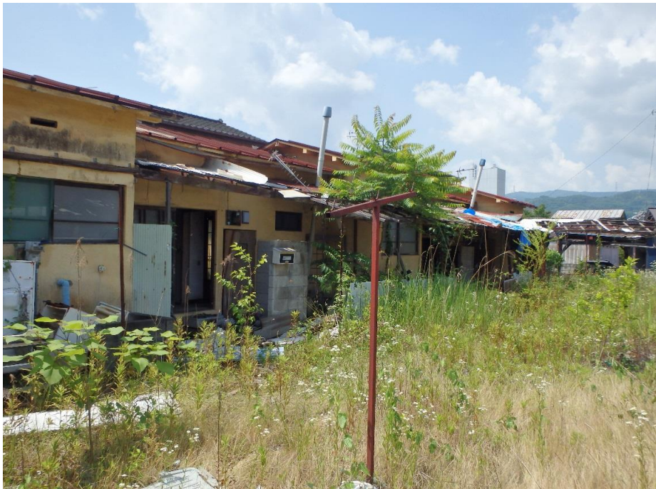
敷地内東側から西側を撮影
