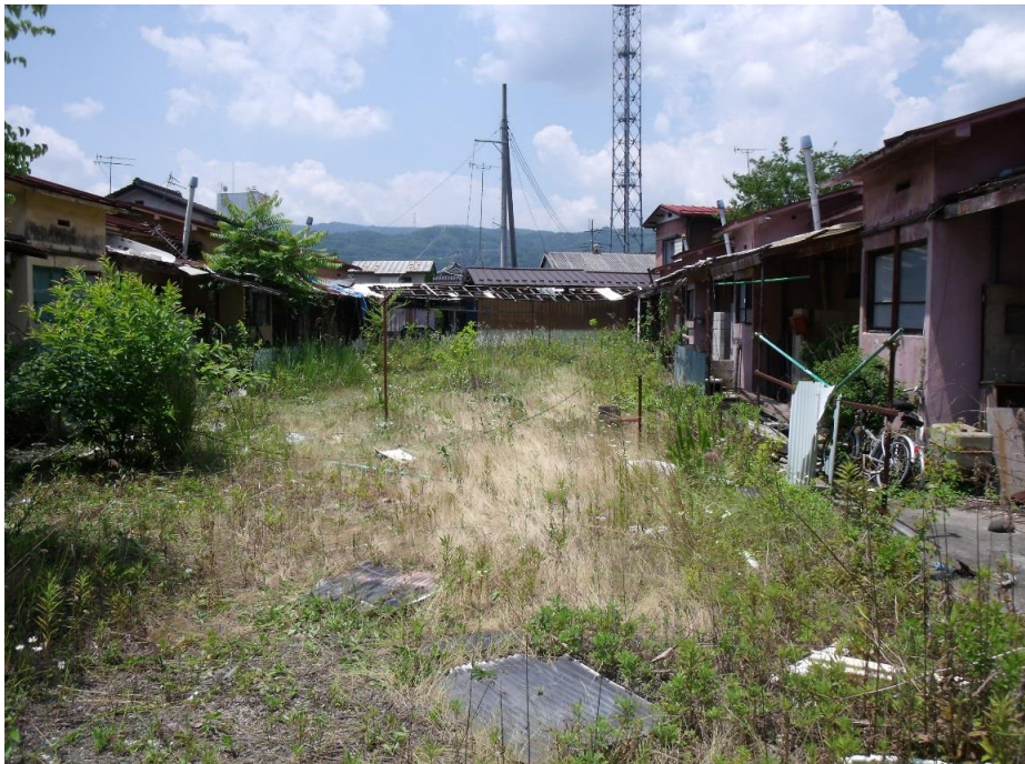
敷地内東側から西側を撮影
