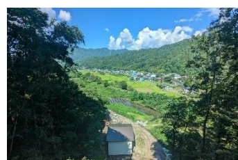
▲ 平川小水力発電所（利根町平川）
