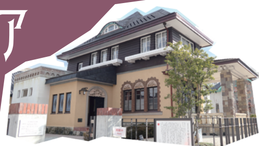
旧土岐家住宅洋館
