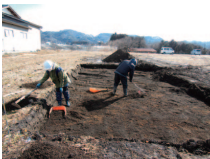
新浄水場建設予定地
