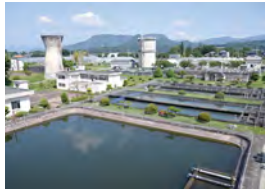
沼田市浄水場
