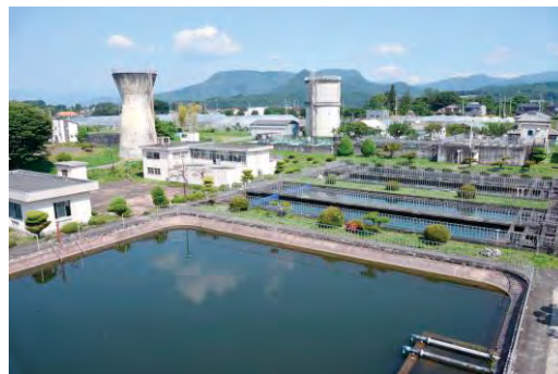
現在の沼田浄水場の様子
